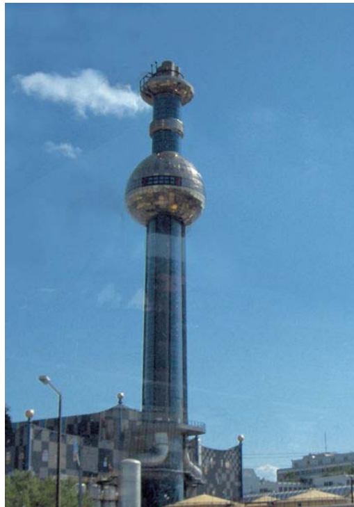
Figure 2 : Incinérateur de Vienne, en fonction depuis 1992. Il assure le chauffage d'eau pour un réseau de chaleur.
